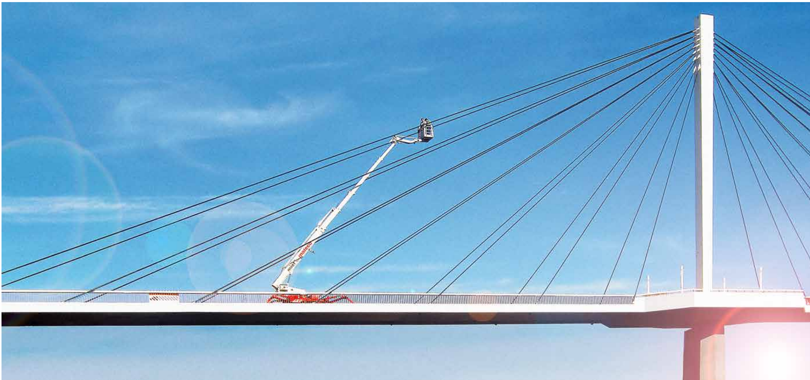
Die Abspannseile und der Turm der Fußgängerbrücke Collini-Steg in Mannheim müssen regelmäßig überprüft werden. Die Abteilung für Brücken- und Bauwerkserhaltung der Stadt setzt dabei auf die Zuverlässigkeit und bekannte Qualität von mateco. Vier Tage dauerte der Einsatz an der Brücke, die zur Eröffnung der Bundesgartenschau 1975 gebaut wurde.
