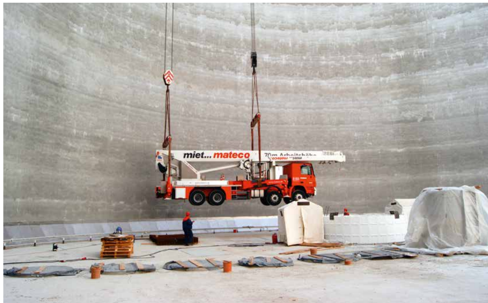
Kranhub-Großeinsatz in Zuckersilo Um die Dachkonstruktion in einem Silo anzubringen sowie Netze zu befestigen, wurden mateco Arbeitsbühnen vom Typ LT 700 K D sowie XTG 500 u. a. mit zwei Autokränen in die Baustelle eingehoben.
