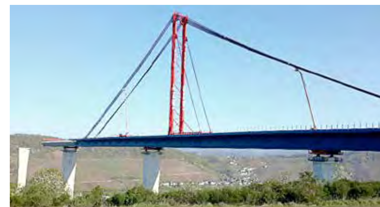
Die Hochmoselbrücke in Rheinland-Pfalz gilt als größtes Brückenbauprojekt Europas. 1,7 km lang und 160 m hoch.
